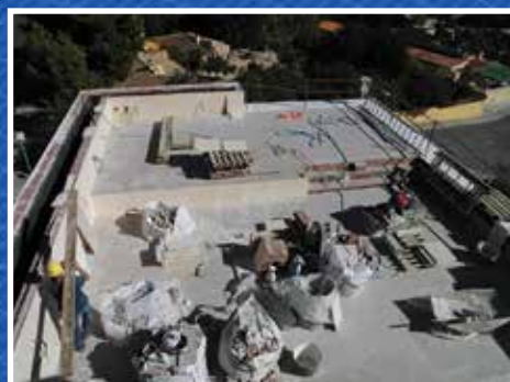
Alltid mye rot på et uferdig hus
