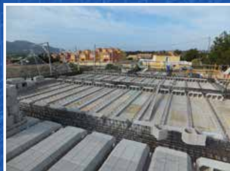
Gulvet i kaféetasjen legges
