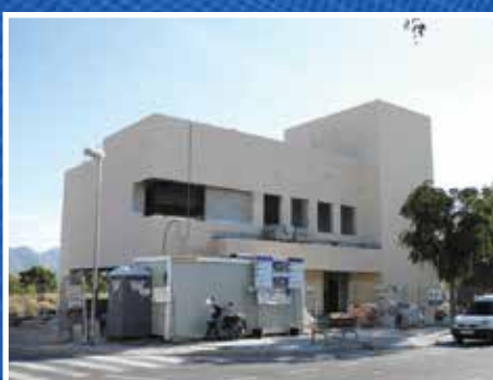
Utvendig kledning er på plass
