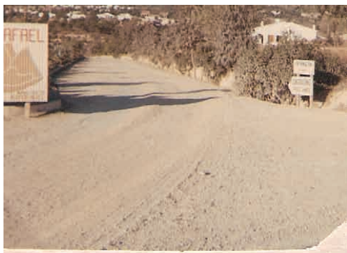
Veien inn til urbanisasjon San Rafael
